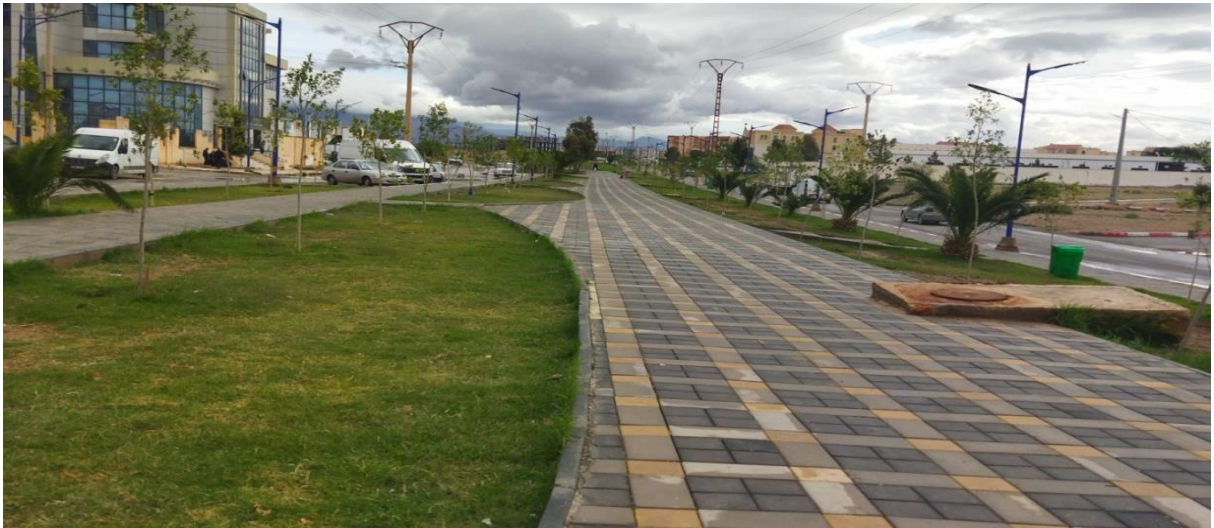
FIGURE 29 Préparation finale de l'espace vert
