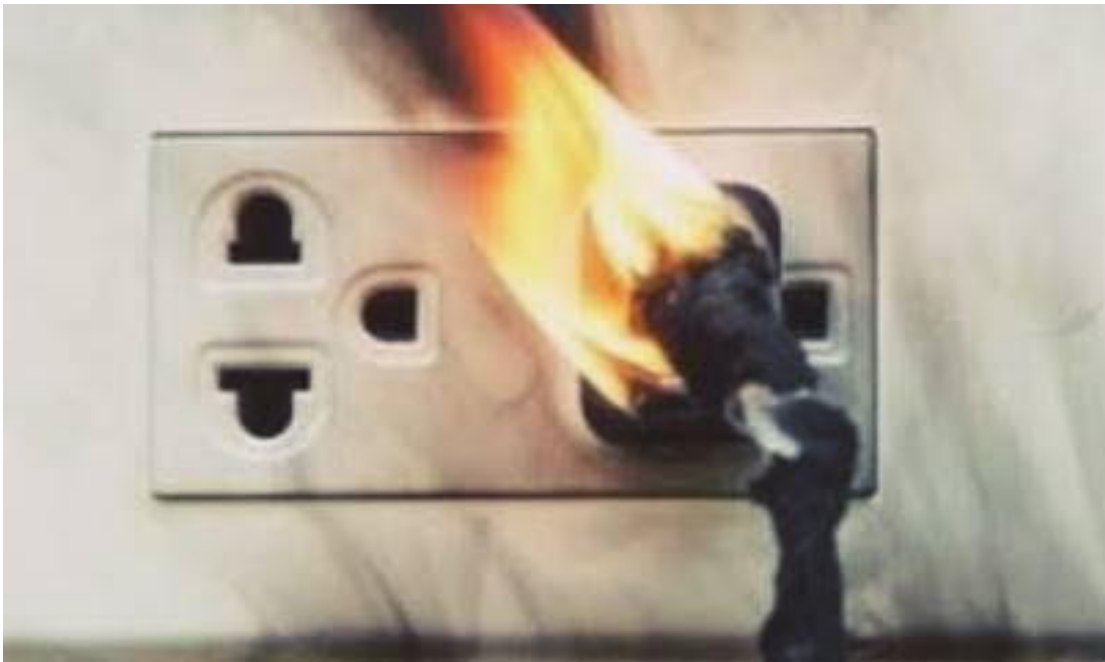
Figure I.3: Risque d'étincelle électrique en raison de l'humidité.
