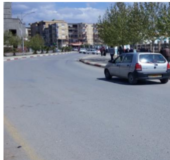
Figure n°168 : Etat de la route. Source : Auteur 2017.
