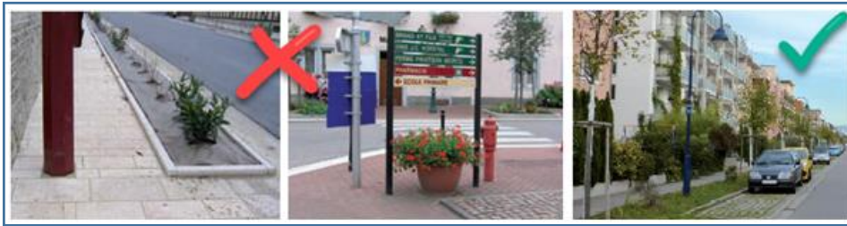
Figure n°29 : Obstacles liés aux équipements relatifs à la circulation. Source : CERTU, encombrement des trottoirs.
