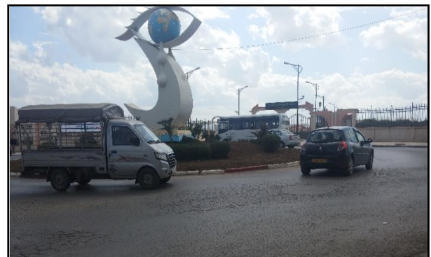
Figure n°208 : état de la route. Source : Auteur 2017.
