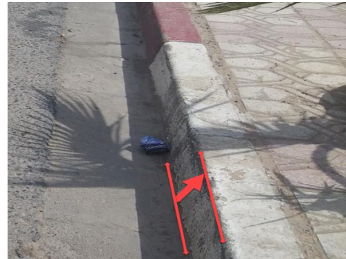
Figure n°195 : hauteur du trottoir. Source : Auteur 2017.
