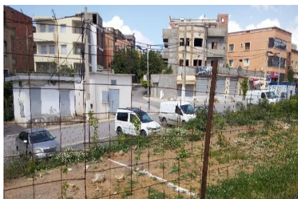
Figure n°115 : Quartier résidentielle. Source : Auteur 2017.
