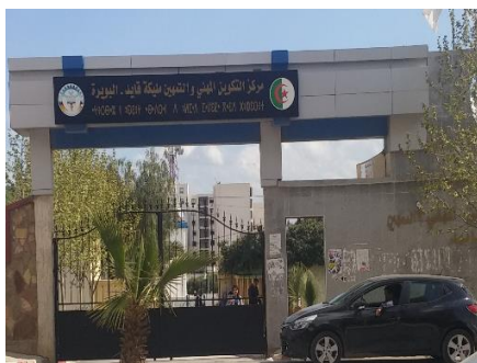
Figure n°126 : centre de formation Professionnelle de Bouira. Source : Auteur 2017.
