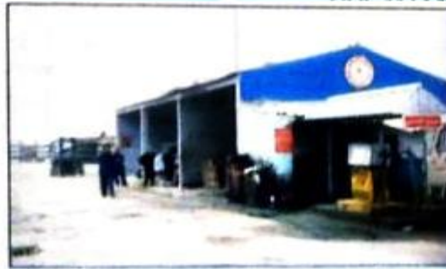
Ph n° 09 : Bloc d'entretien + poste carburant
