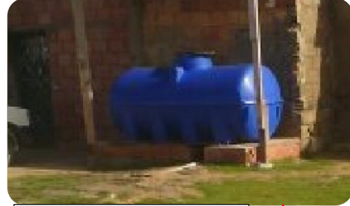
صورة رقم 17: تمثل خزان للمياه الصالحة
