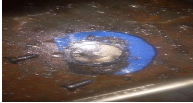
Fig.III.26: des vis de fixation de la couverture.
