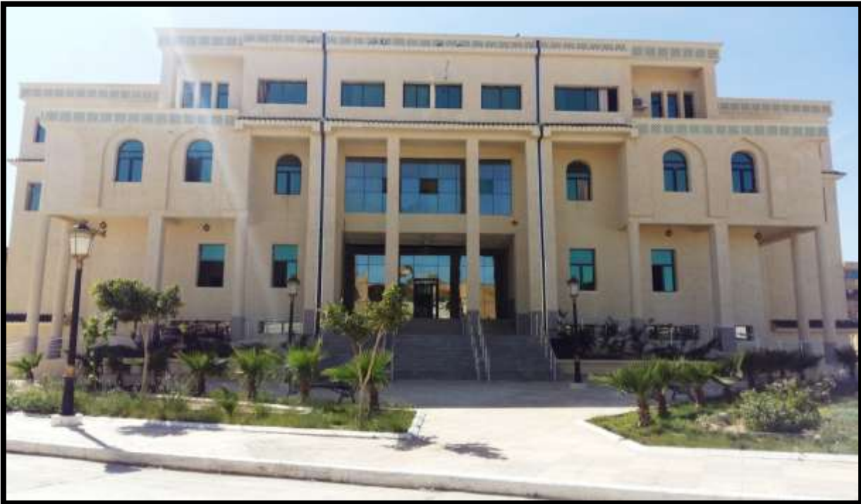
الصورة رقم(03) : توضح واجهة خلفية لمحكمة المسيلة
