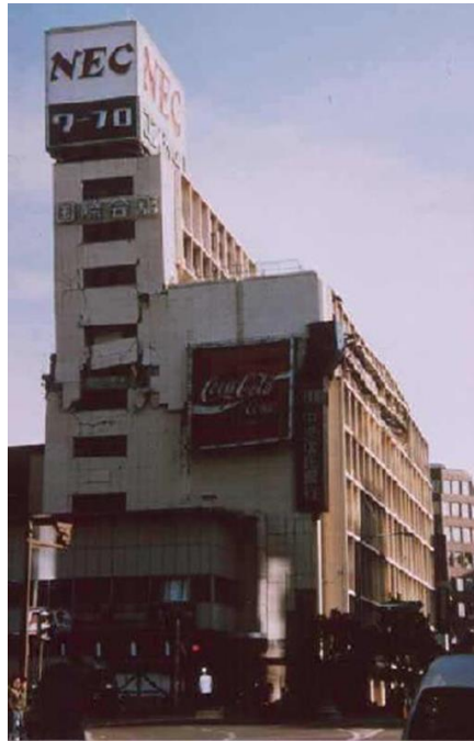
Figure II.6 : Dommages dus à l'irrégularité en élévation [25].
