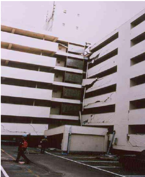
Figure II.5 : Dommages dans les angles rentrants dus aux oscillations différentielles, (séisme de Kobé, Japon 1995) [21].
