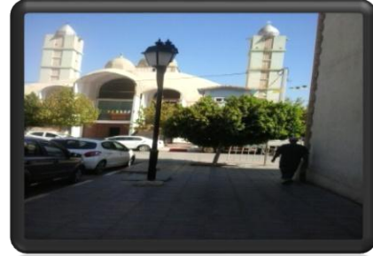
صورة رقم 10: توضح مسجد
