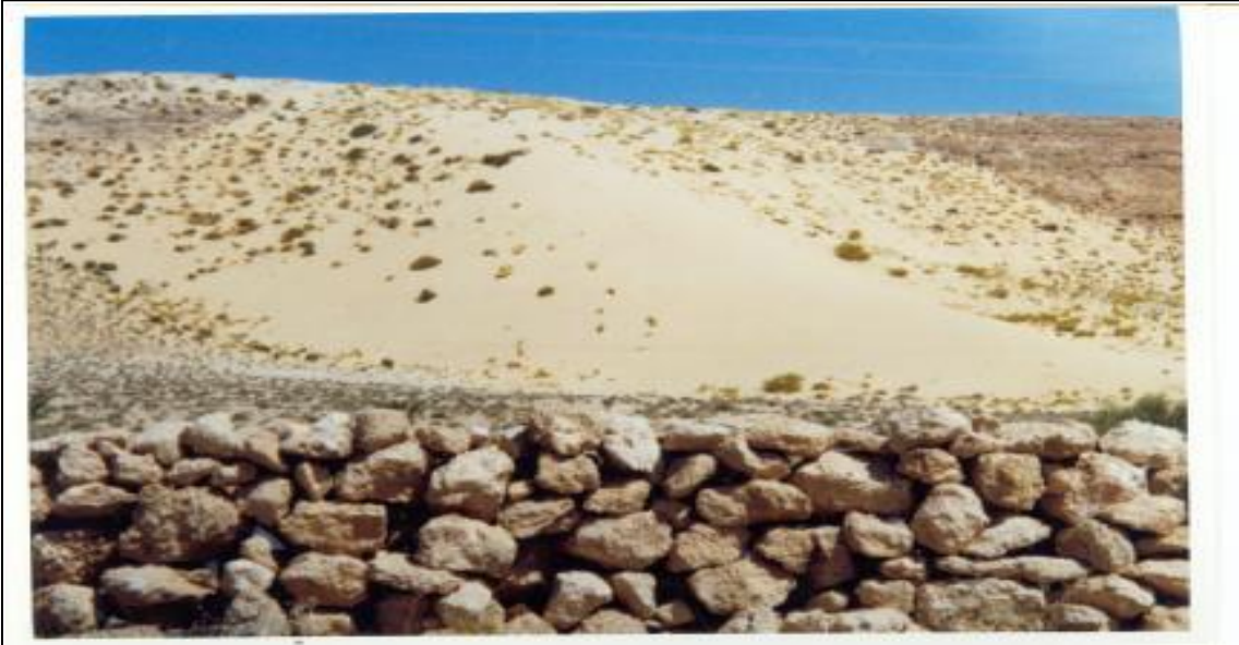
صورة 08: توضح التثبيت باستعمال حواجز الحجارة.
