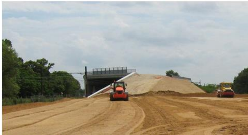
Figure I.1 : Remblai d'un pont routier
