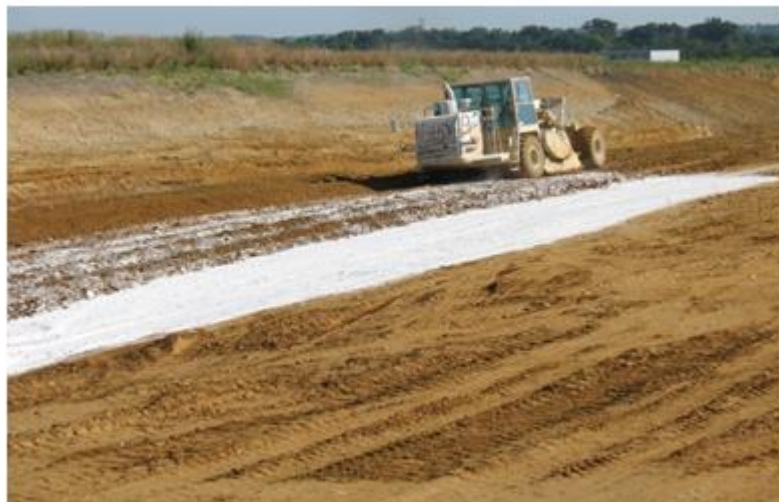
Figure I.8 : Traitement à la chaux.
