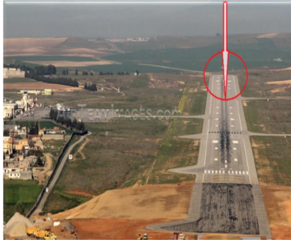
Figure V.2 : Tronçon de l'extension de l'aérodrome d'Ain Arnat
