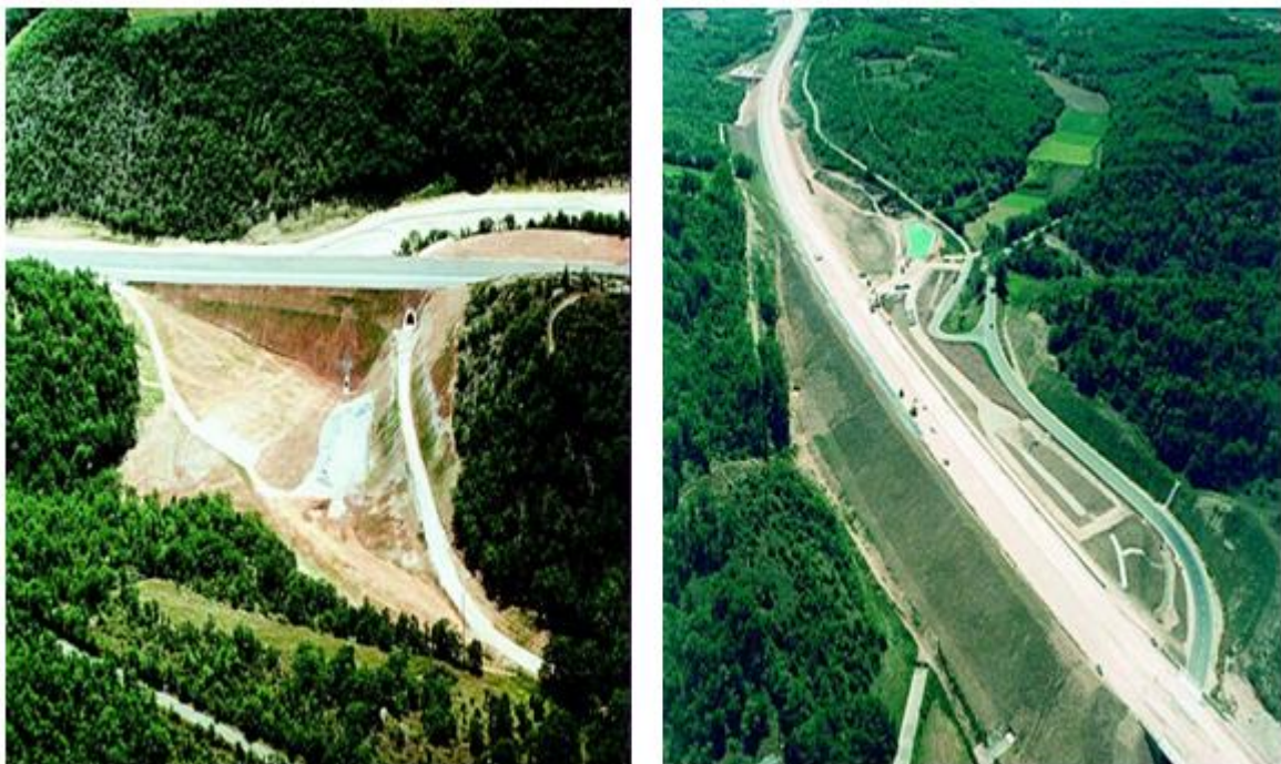
Figure I.13: Exemple d'ouvrages transversaux dans un grand remblai.
