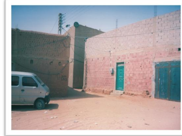
صورة رقم 09: توضيح بناء بمواد حديثة
