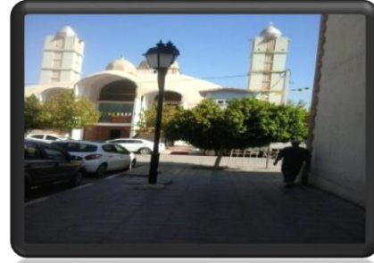
صورة رقم 01: توضح مسجد
