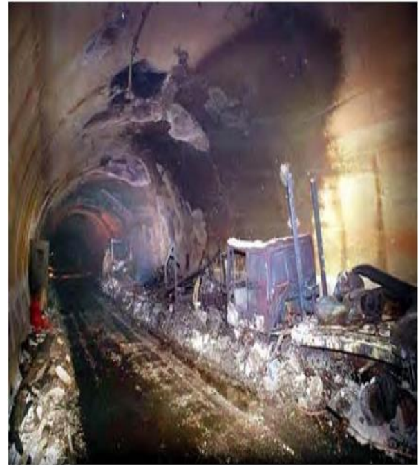
b) Mont Blanc : éclatement du béton.
