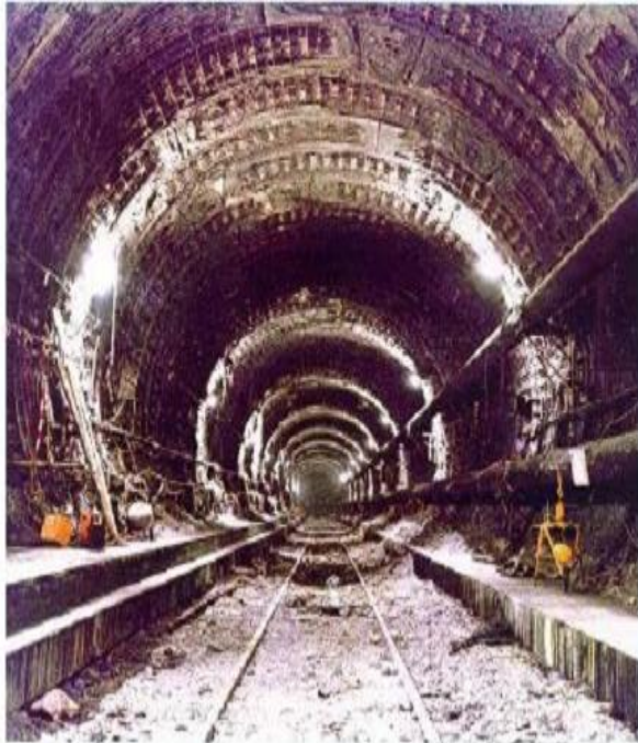
a) Tunnel sous la Manche : fort écaillage du béton.
