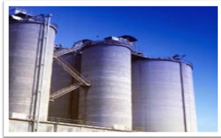
Fig.I.20 : Silos pour stockage le ciment
