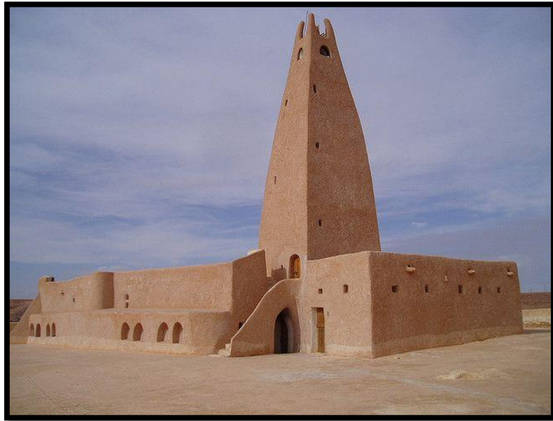
Fig. N02 : Bâtiment traditionnel mosquée de Mzab ibadite –Ghardaïa
