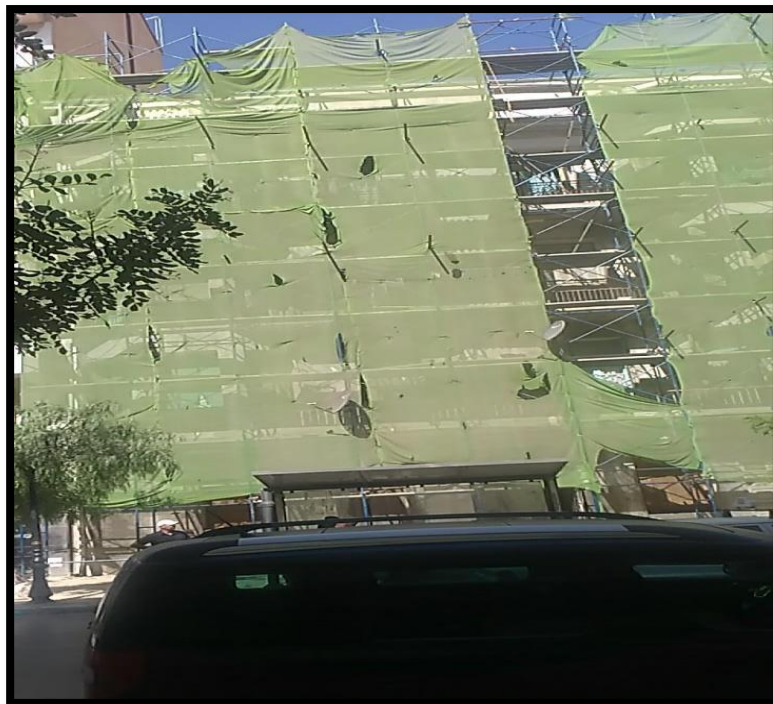
Fig. N 30 : Restauration d'un bâtiment coloniale au centre de vile de Sidi Bel Abbés
