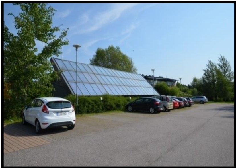
Fig. N 17:des panneaux photovoltaïques
