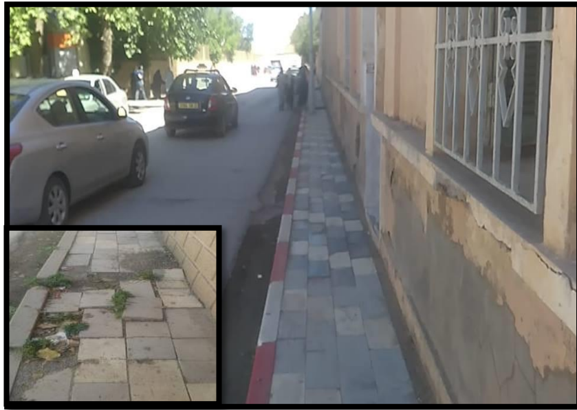
Fig. N 58: Les trottoirs très étroits et endommagés
