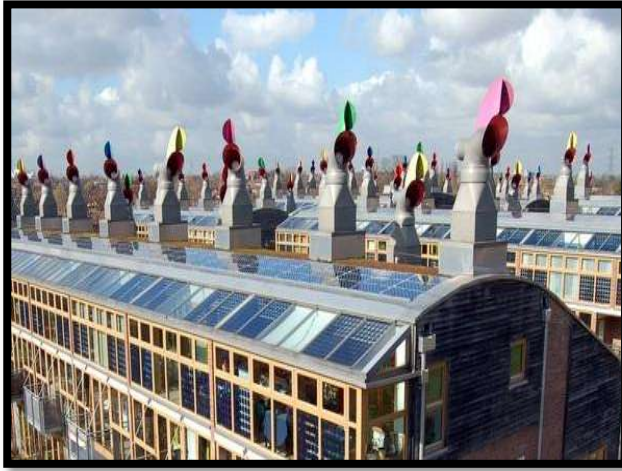
صورة رقم 4: مداخن التهوية الطبيعية والطاقة الشمسية في الحي.
