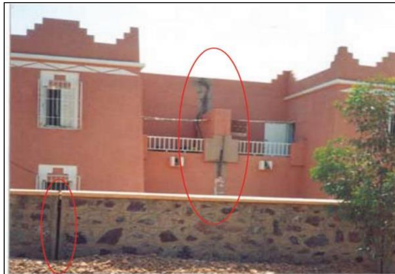
Figure 0.6 : Dommages structurels dus au soulèvement de terrain à Al-Khod Oman
