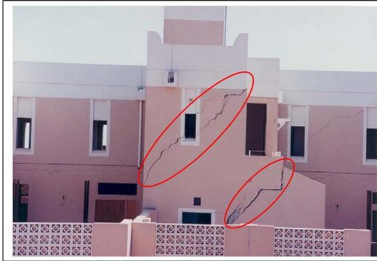
Figure 0.6 : Dommages structurels dus au soulèvement de terrain à Al-Khod Oman
