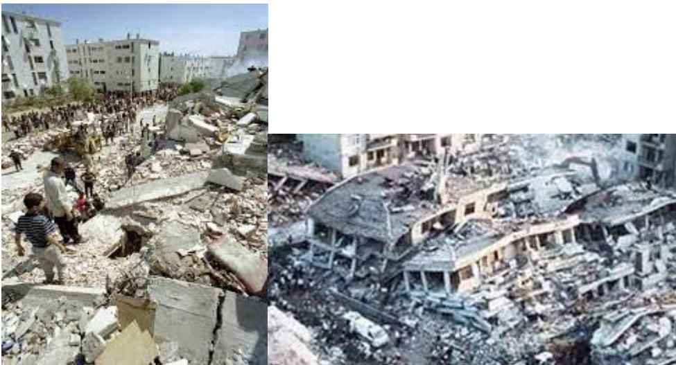
Figure 1.1 : Effet du séisme de Chlef (Algérie, 1980).
