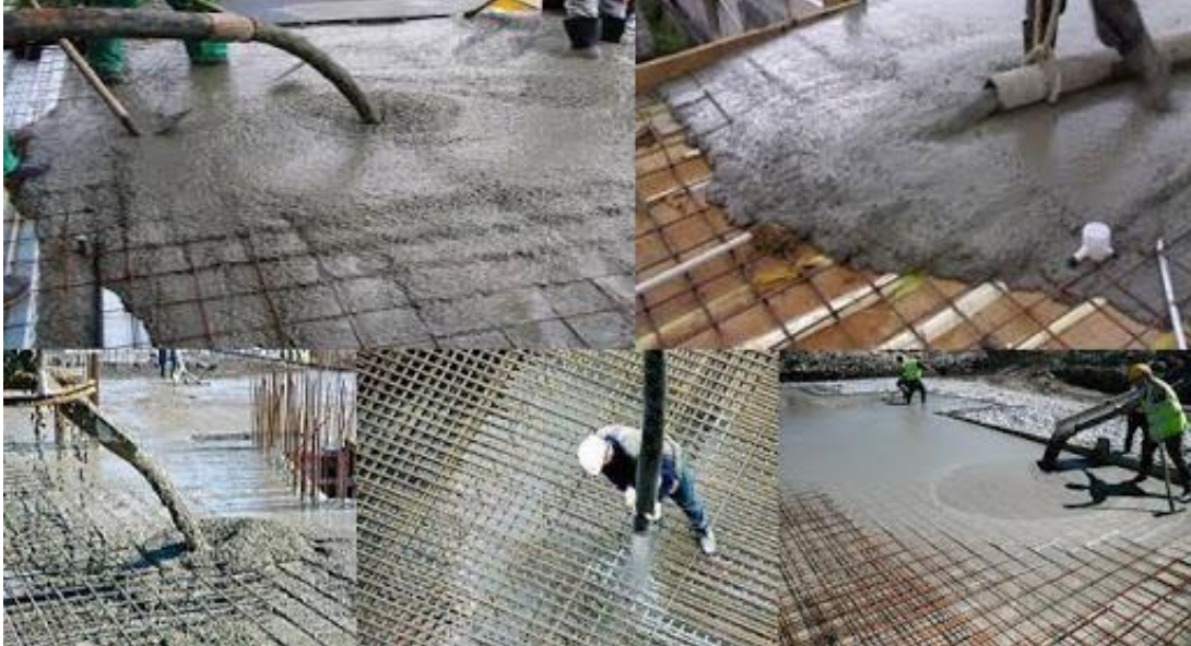
Figure I.9 - Mise en œuvre des BAP [32].
