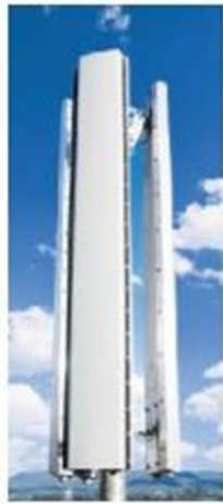
Figure I.7. Remplacement d'une cellule omnidirectionnelle par trois secteurs de 120°
