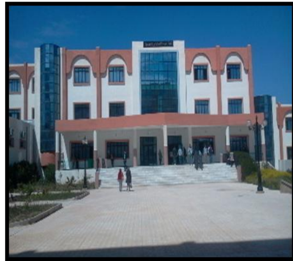
صورة (26): الواجهة قبل التدخل
