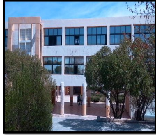
صورة (24) : الواجهة الموجودة
