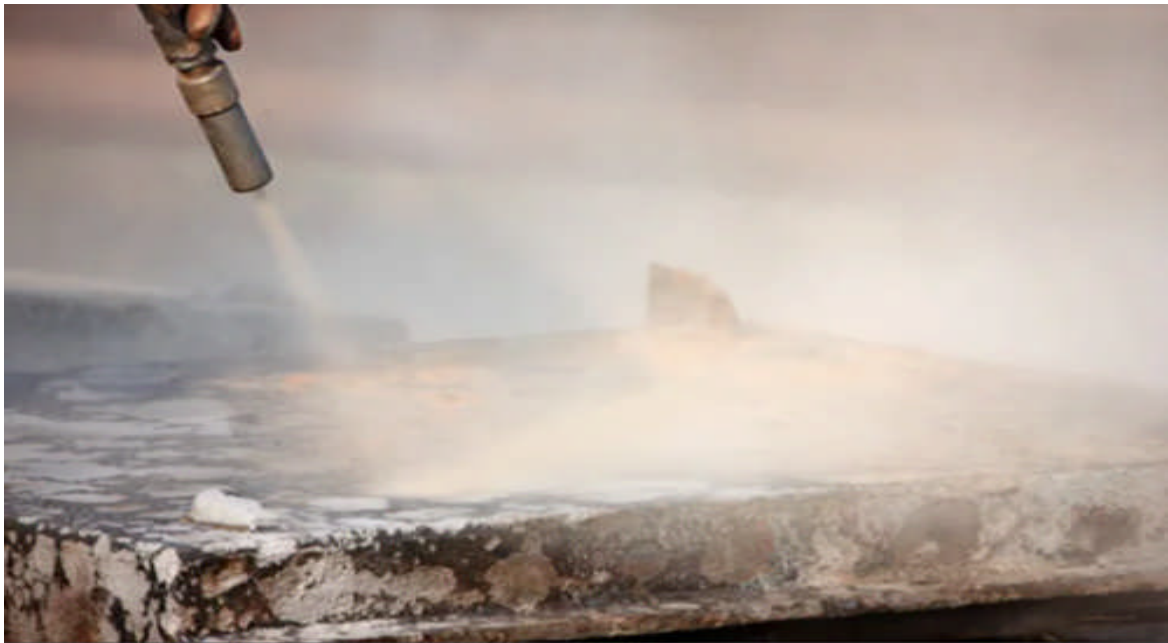
Figure III.9 : L'opération de sablage.
