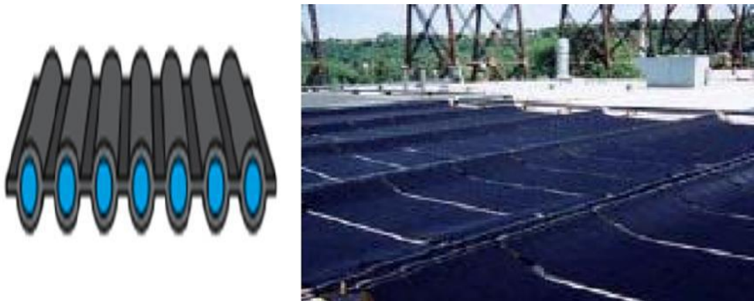
Fig.1-3. capteurs solaires non vitrés à revêtement sélectif [7].
