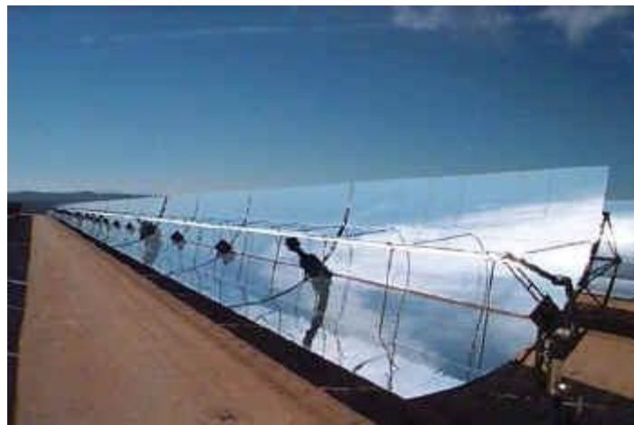
Fig. 1-9. Concentrateur cylindro-parabolique [9].
