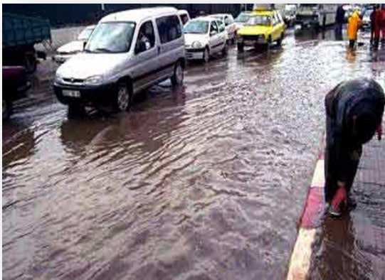
Photo 19 : blocage dans les avaloirs à IBN BADISS
