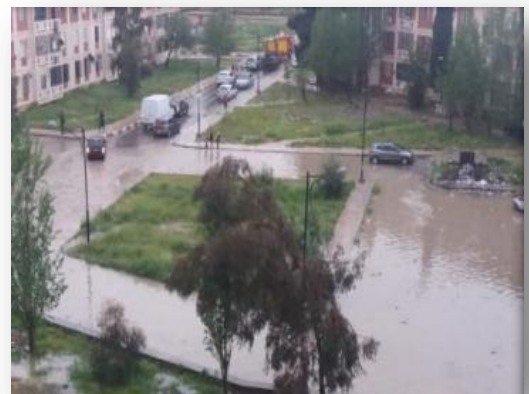
Photo 18 : mauvais réseau d'assainissement à EPLF
