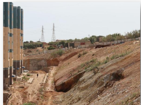
Photo 22 : Glissements de terrain Quartier 1900 logs
