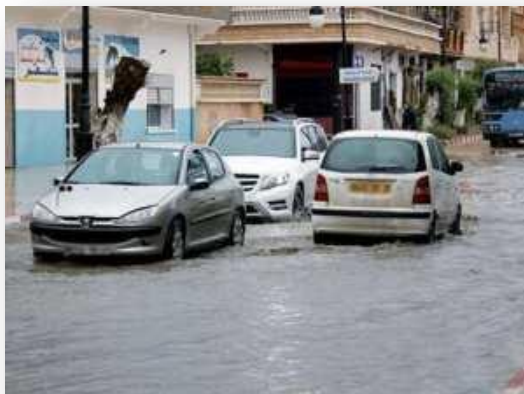
Photo 17 : mauvais réseau d'assainissement à CITE 12
