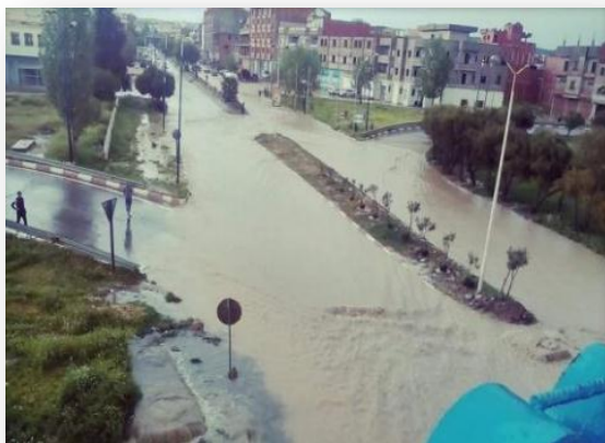
Photo 15 : mauvais réseau d'égouts à RASS SOUG
