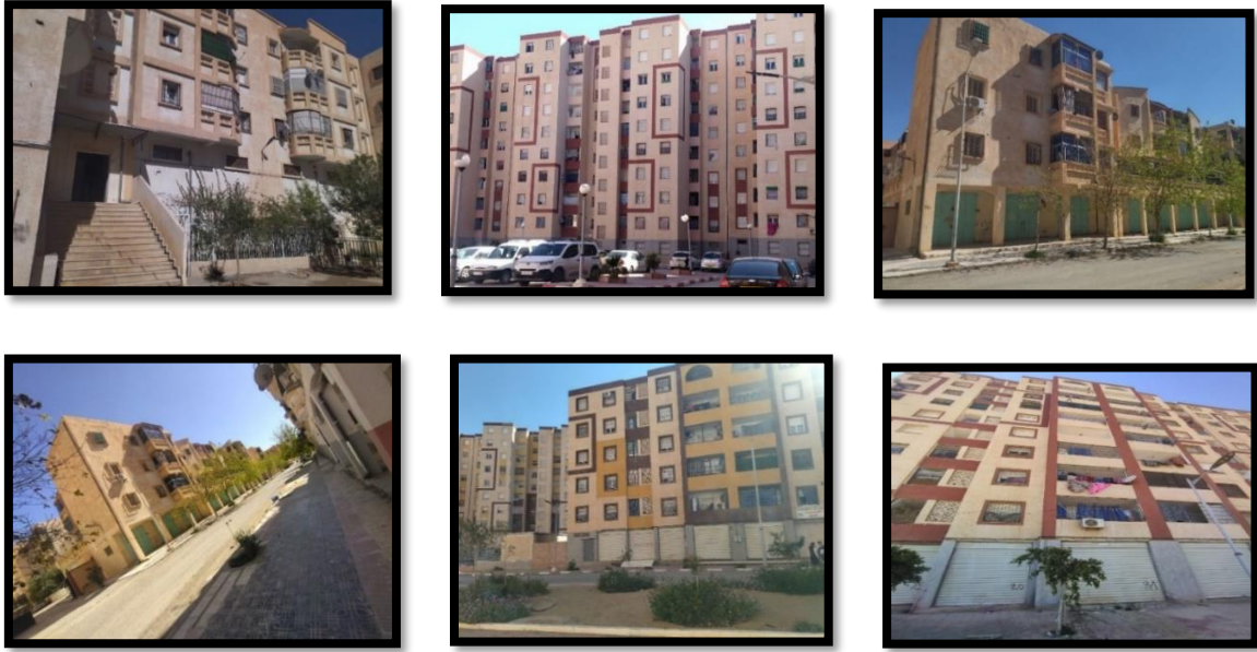
Fig. N05 : des photos réelles de l'état des bâtiments dans la zone d'étude
