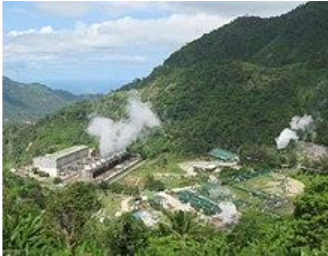
Figure (I.10) : La centrale géothermique de Palin Pinon (Philippines), le plus profond puits est de 3 800 m [13]
