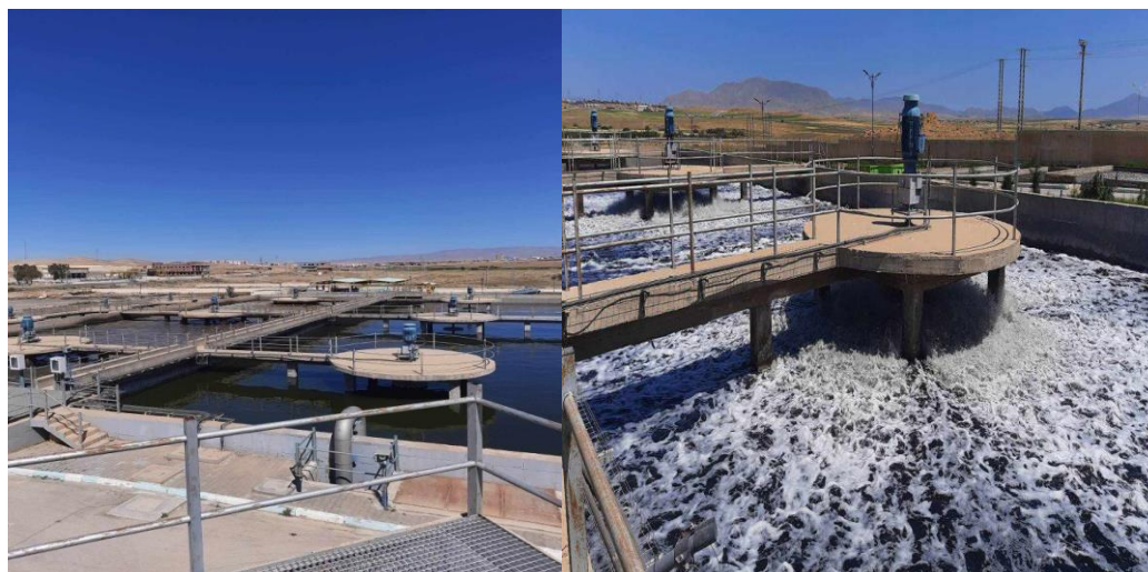
Figure 18. traitement biologique de STEP de « SIDI AISSA ».
