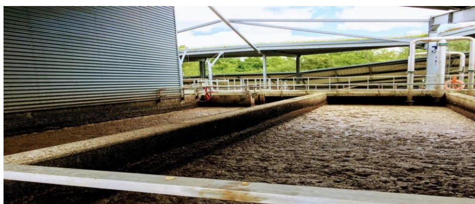
Figure 4. Traitement biologique dans un bassin de décantation [33].
