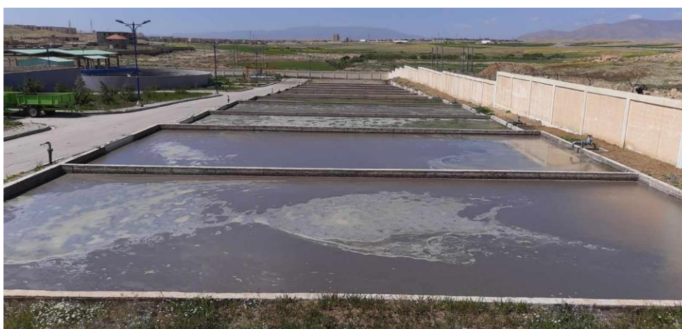
Figure 20. Lits de séchage de STEP de SIDI AISSA.
