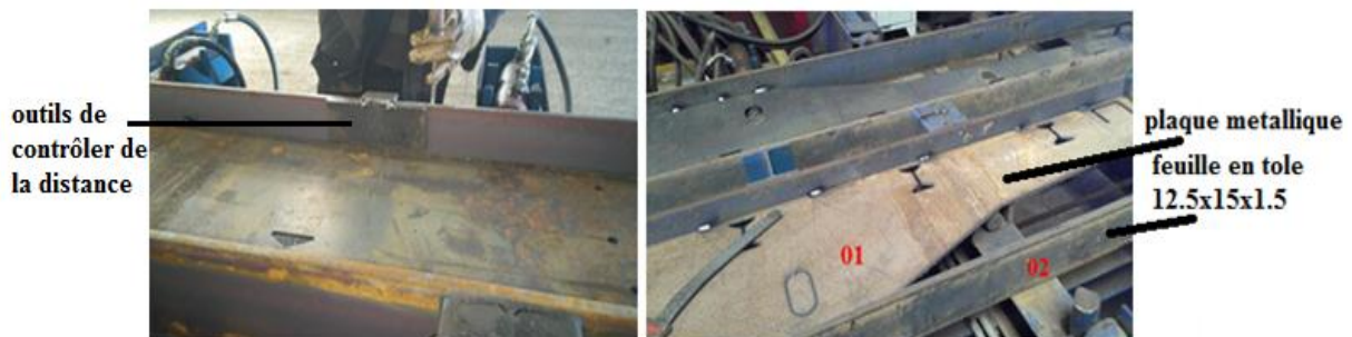
Fig. III.3: Pointage des plaques et feuilles métalliques pour produire les poutres. -ACI-
