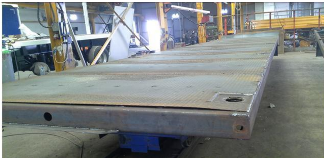
Fig. III.12. : Soudage de la plate-forme du châssis -ACI-
