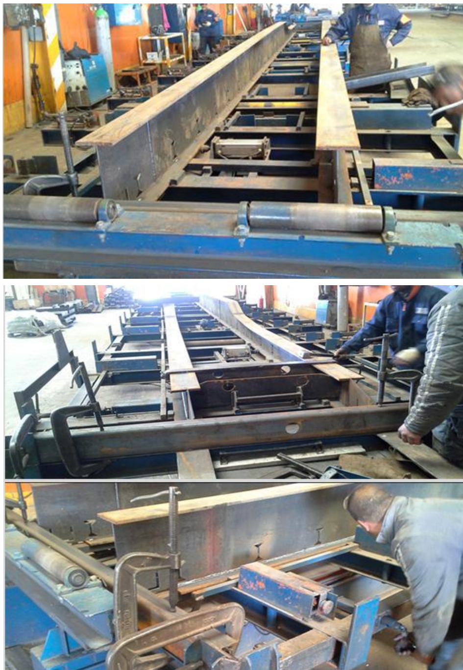
Fig. III.6. : Méthode de fixation des traverses sur le gabarit -ACI-
