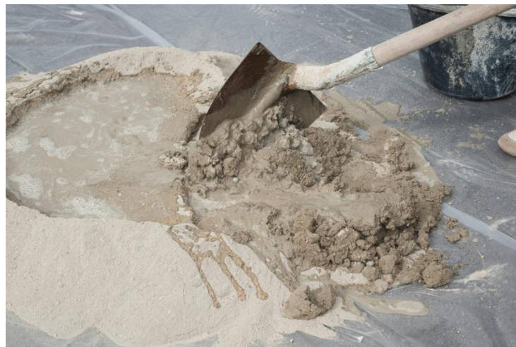
Figure.IV.1. Exemple d'un gâchage de mortier.
