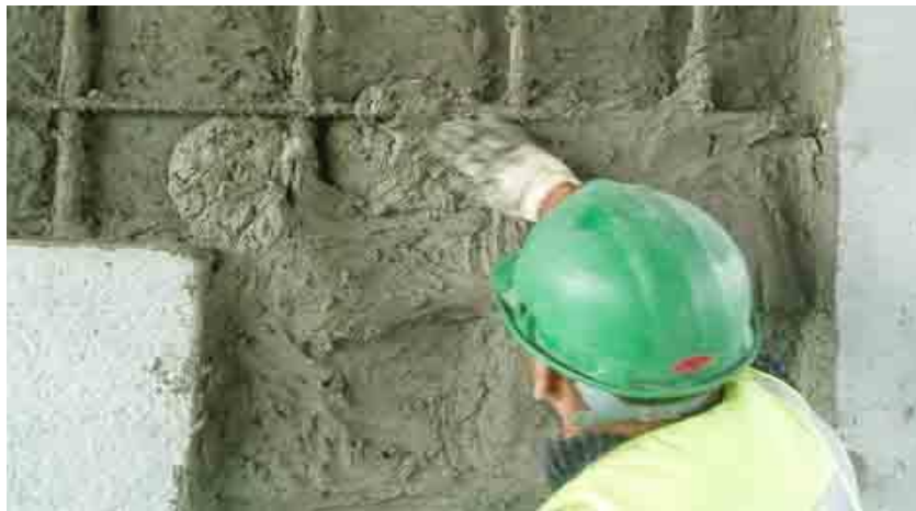
Figure.I.5 Utilisation mortier pour réparations structurelles.
