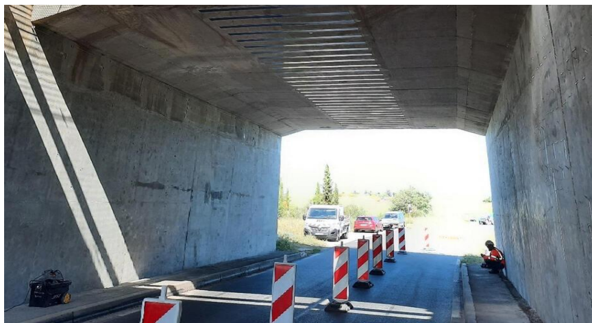
Figure.I.6 Utilisation mortier pour travaux de génie civil.
