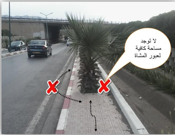
صورة رقم 02: وجود عوائق على الرصيف المصدر: الباحثة 217
