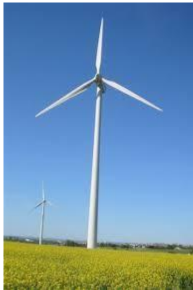
Figure I.4: Eoliennes à axe horizontal.
