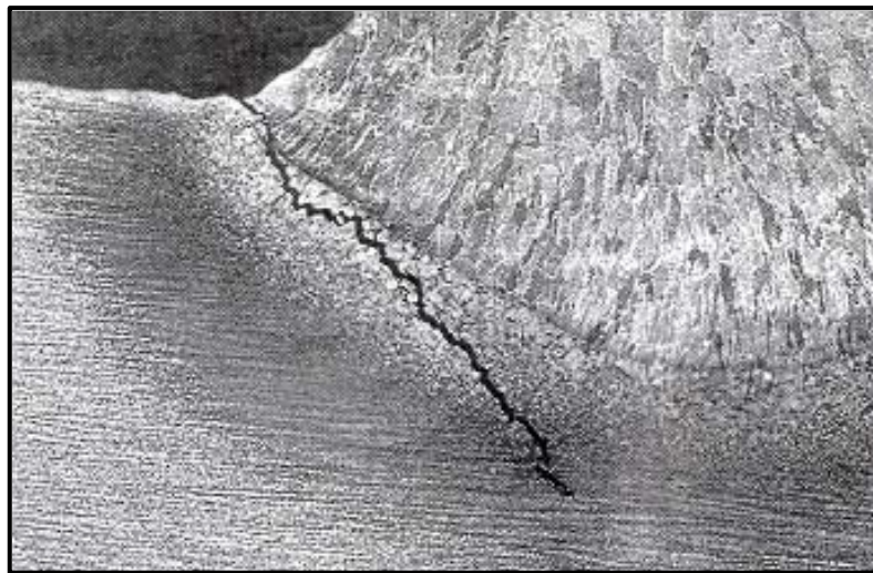
Fig.2.1.- Fissure dans une Soudure en T:
