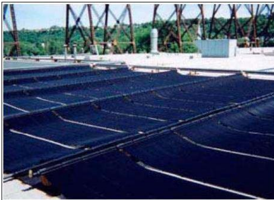
Figure I.10 : Capteur moquette pour le chauffage des piscines
