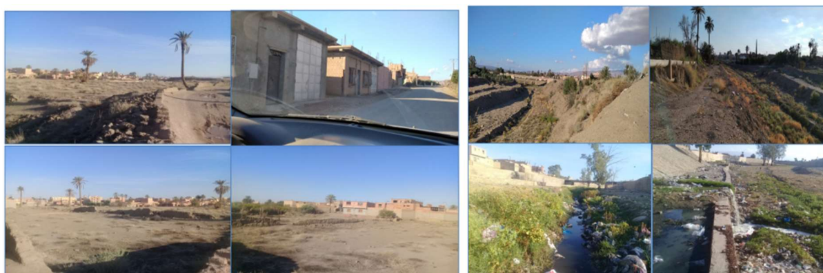
Figure 8 : L'état de dégradation du paysage urbain et du oued k'sob
