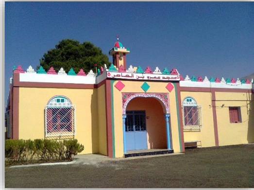
صورة رقم 06 توضح مسجد
