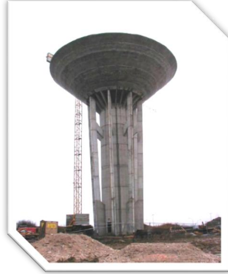
صورة رقم 01: برج مياه (500م 3 )
