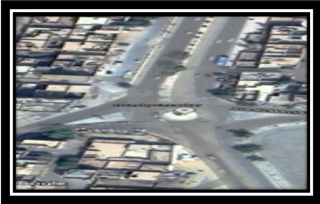
صورة 15: توضيح مفترق بسم الله قبل عملية التهيئة
