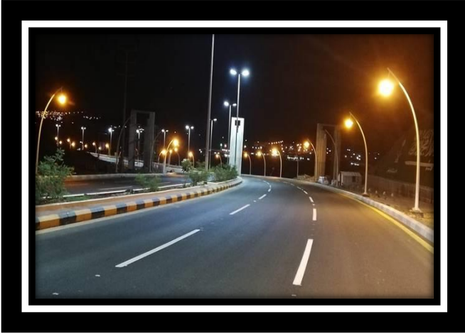
صورة 12: توضح حالة الطريق بعد التصليح
