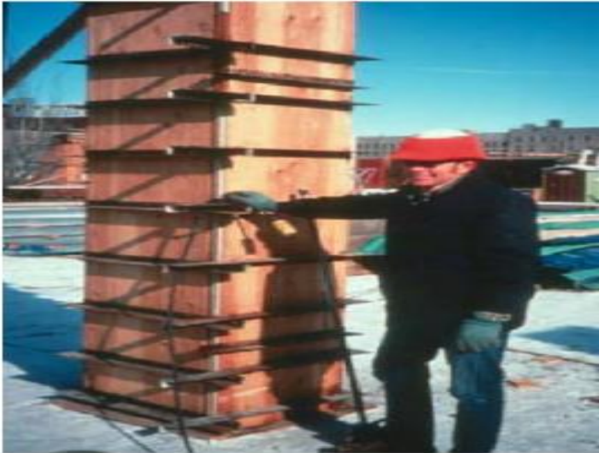
Figure III-5: Maintien des coffrages en place Recouvrant la surface du béton. [22]
