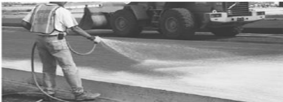
Figure III-4: Pulvérisation du produit de cure à la surface du béton.[21]
