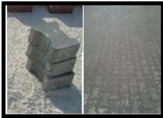
Photo n°16 : revêtement avec des pierres préfabriquées
