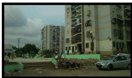
Photo n°31: la placette détériorée
