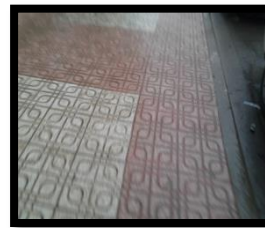
Photo n°18 : revêtement avec du carrelage
