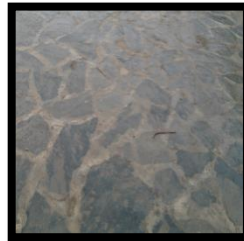
Photo n°17 : revêtement avec du basalte
