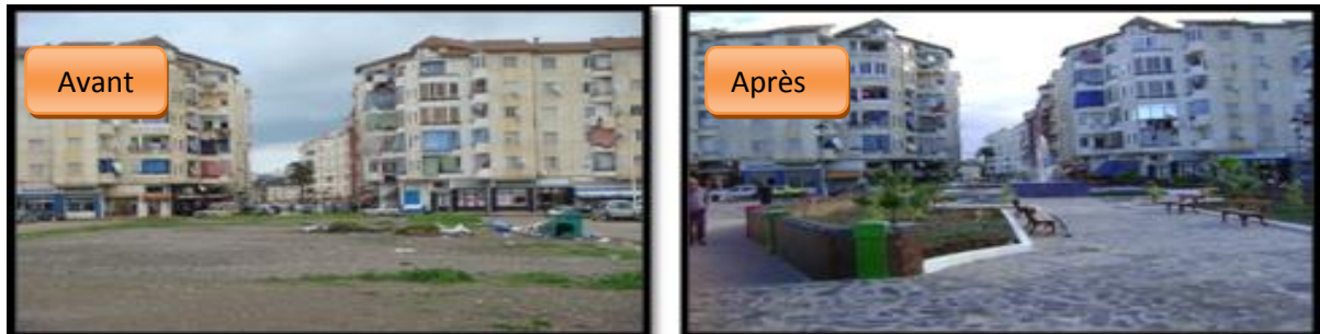
Photo n 01: aménagement d'une placette (travaux achevés à 100%).
