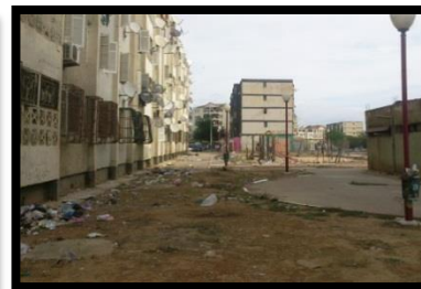
Photo n°28 : espace vert dégradé
