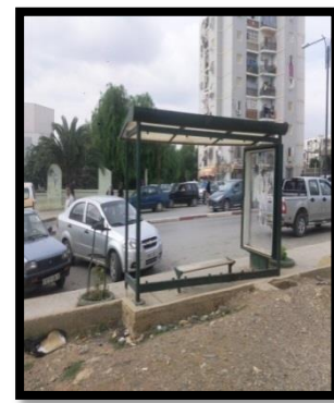
Photo n°25 : arrêt de bus de la ligne n°05 avec un abri de bus détérioré
