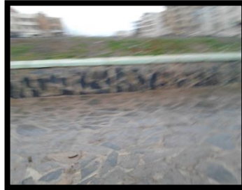
Photo n°06 : Mur de soutènement
