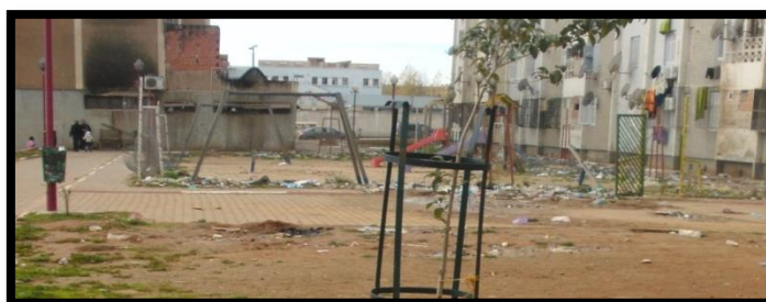
Photo n°30 : une aire de jeu détérioré
