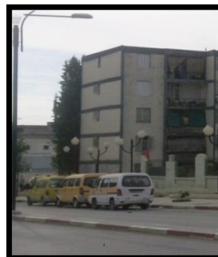
Photo n°24 : arrêt de mini bus , sans abri de bus
