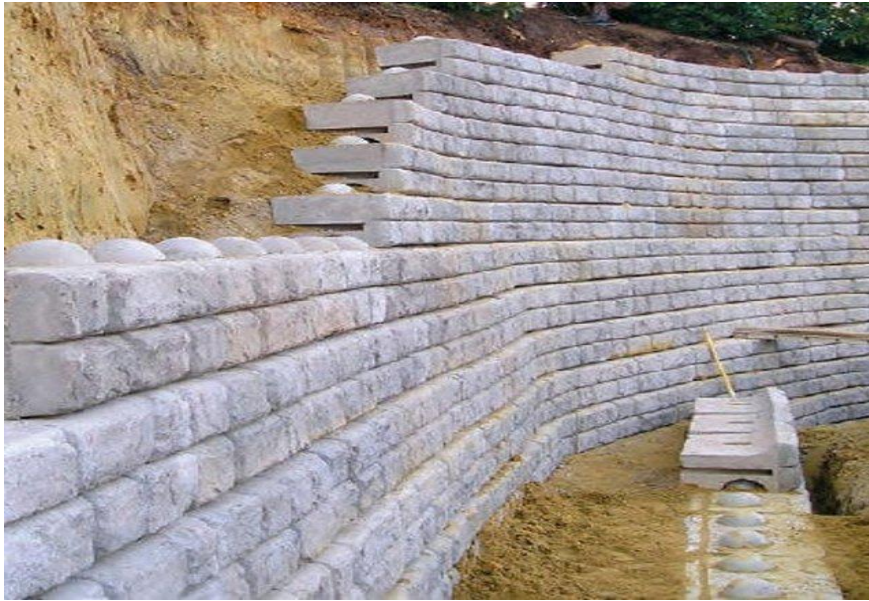
Figure : 1.18 : Un ouvrage rigide Le mur poids
