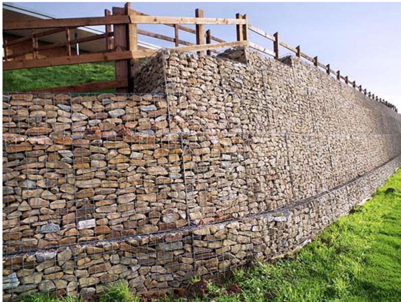
Figure : 1.19 : Ouvrage souple Un gabion
