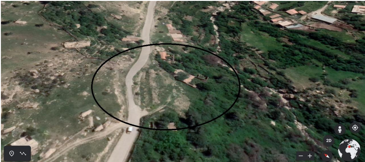
Figure3.1 : Vue de la route avec la zone ou les instabilités sont visible (Google Earth).
