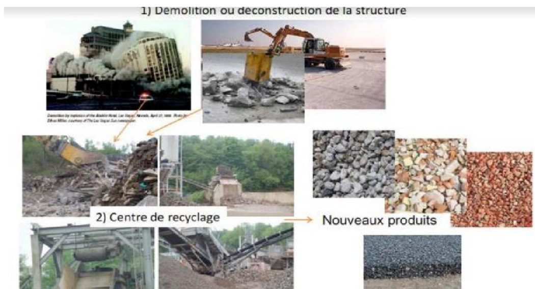
Figure II.1. Les étapes de la production des granulats recyclés [23].
