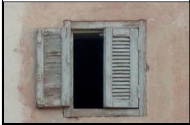
Figure 46 : Photo d'une fenêtre
