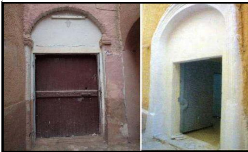
Figure 48 : Photos des portes
