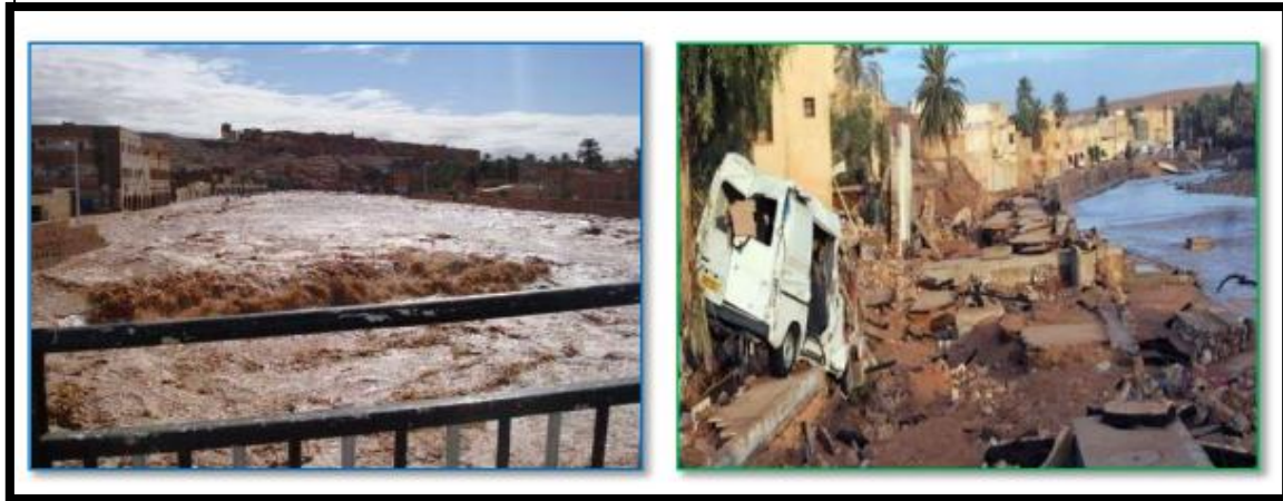
Figure 55 : Photos des vestiges d'inondation.
