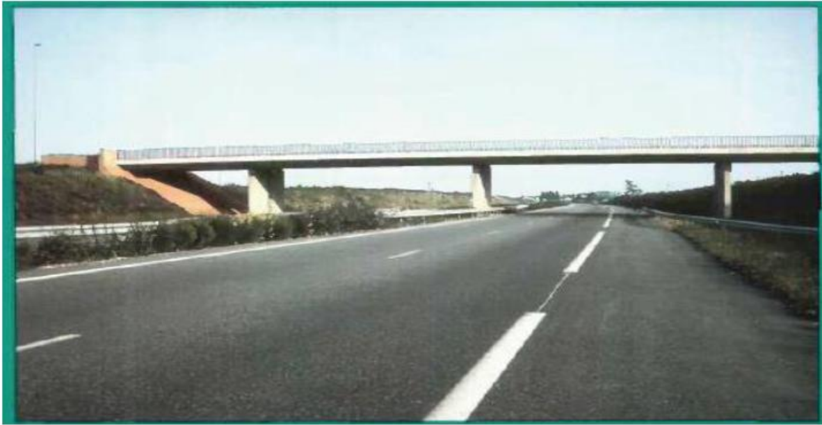
Figure I-3 : photo représente un pont-dalle.
