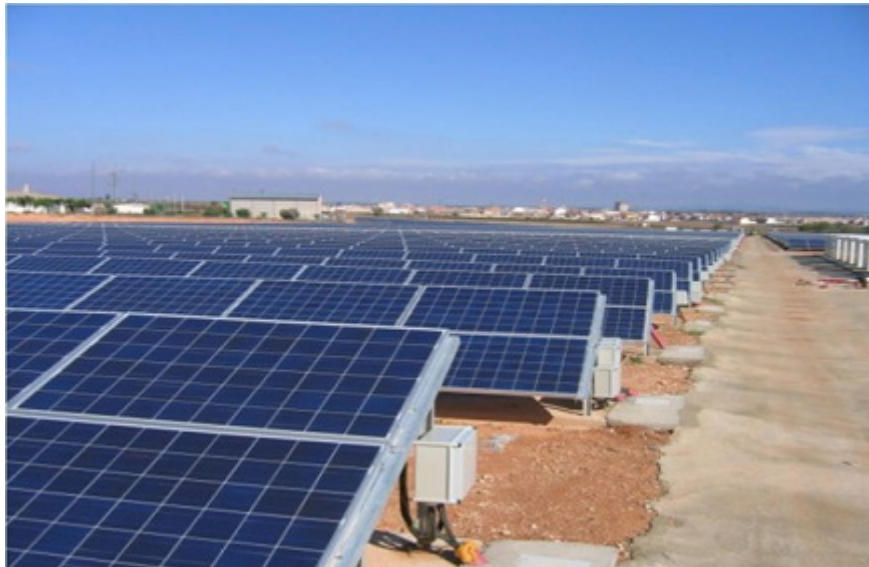
Figure(I.21) : La centrale photovoltaïque de Birr Rebaa a Ouargla de 10 mégawatts. [20]
