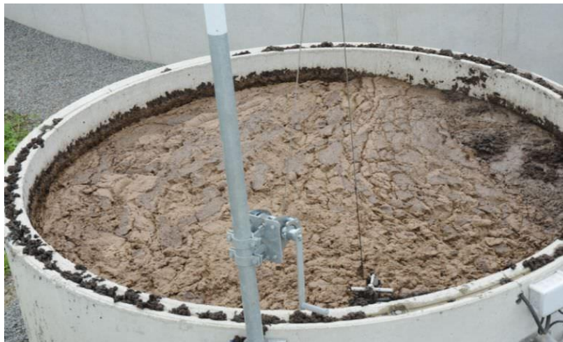
Figure II.4 : Station d'épuration à boues activées
