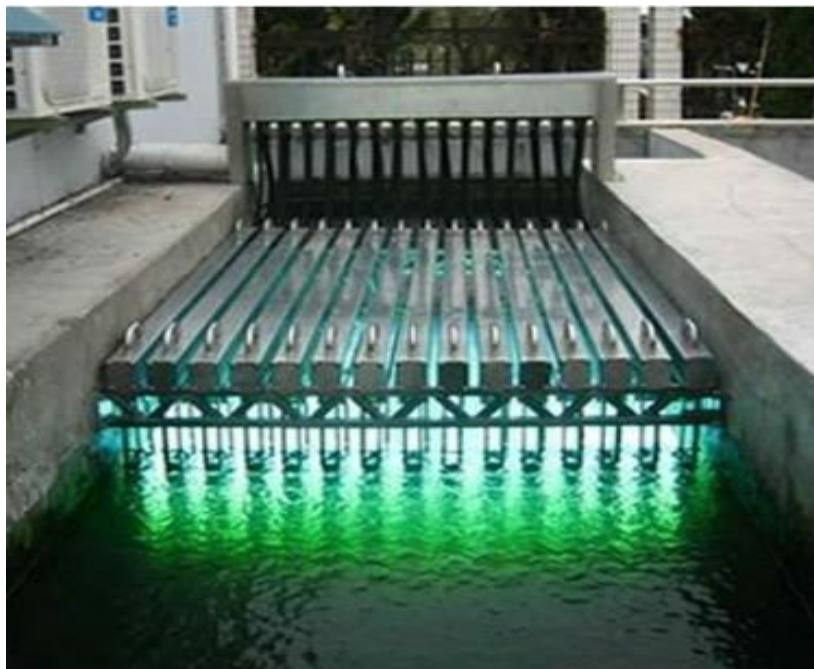
Figure II.8 : Traitement des eaux usées par ultraviolets (UV)
