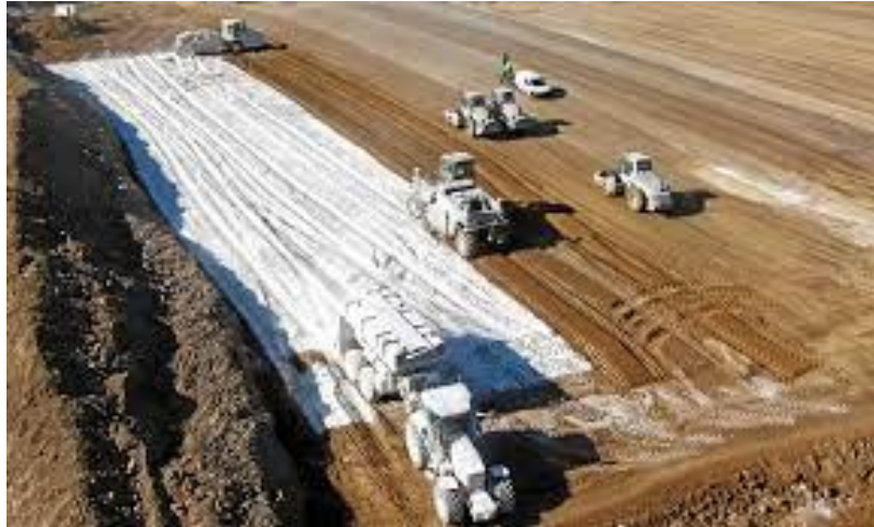
Figure I.6 : Traitement à la chaux.
