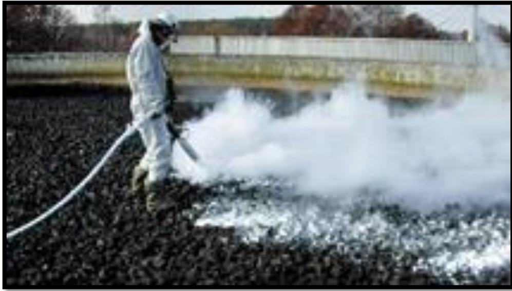
Figure I.4 : La congélation du sol sur chantier.
