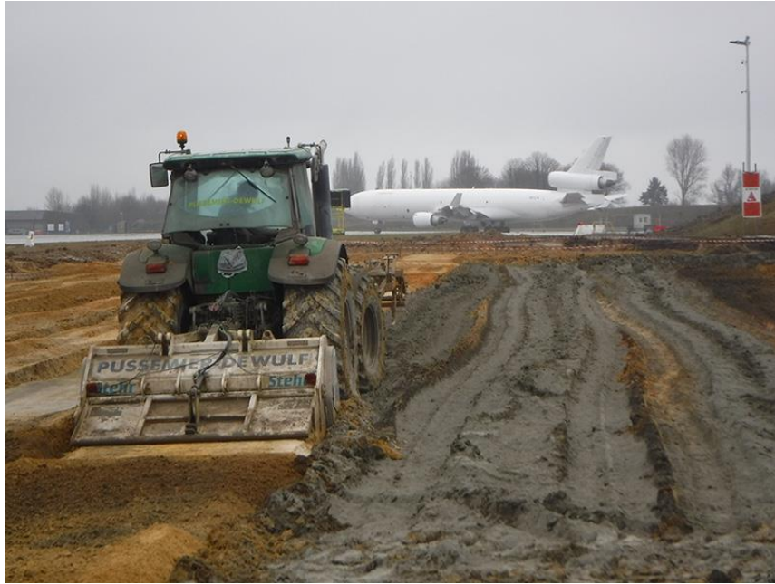
Figure I.7 : Traitement au ciment.
