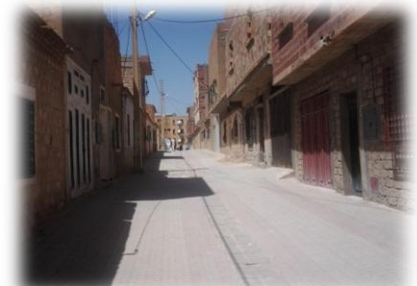
الصورة رقم(35) عدم تحسين واجهات للمساكن
