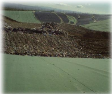
الصورة رقم(53) طمر النفايات
