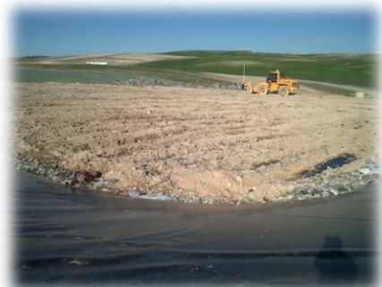
الصورة رقم(51) طمر النفايات
