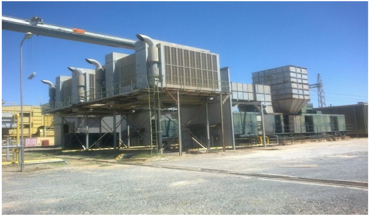
Figure III:1 Etablissement de central électrique
