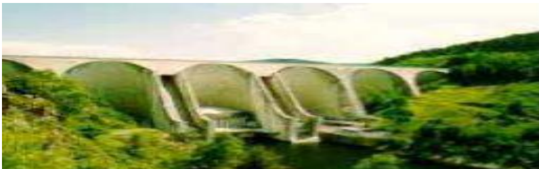
Figure 1.4 : Barrage à contre fort (Grandval)
